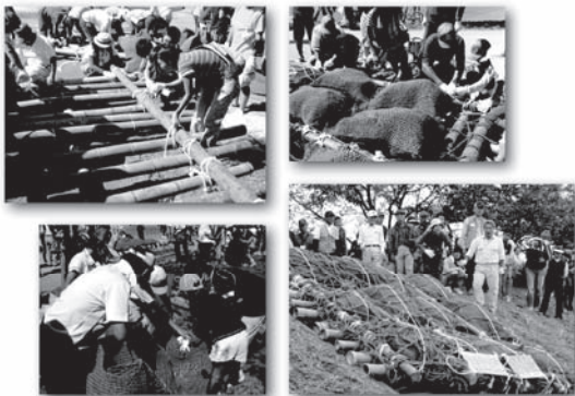
竹と丸太を組んだイカダに、アシの苗を入れた炭袋をのせる。完成した浮島は竹のレールの上を滑らせ湖面に進水する。
