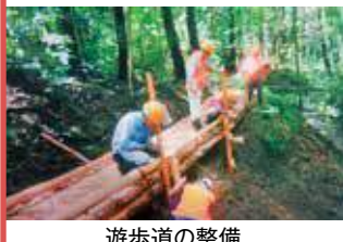
遊歩道の整備
